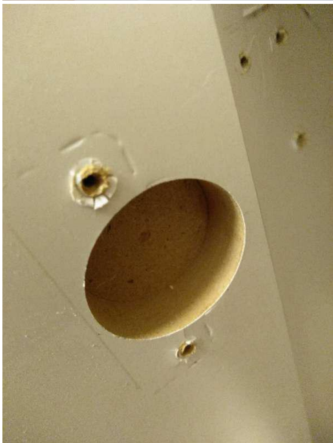
▲上图是门框，下图是门体，从安装锁具的位置能看到内部的密度板材质，说明这个门是最低档的模压门
